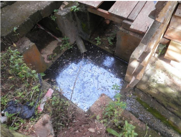
Centrale de LOMIE
