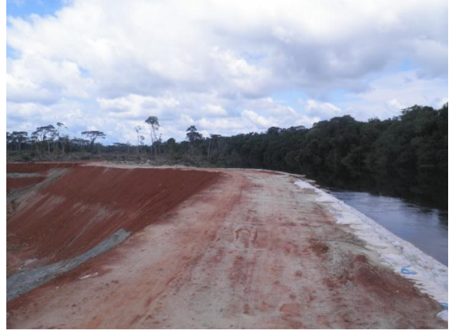
Batardeau pour déviation du cours d'eau
