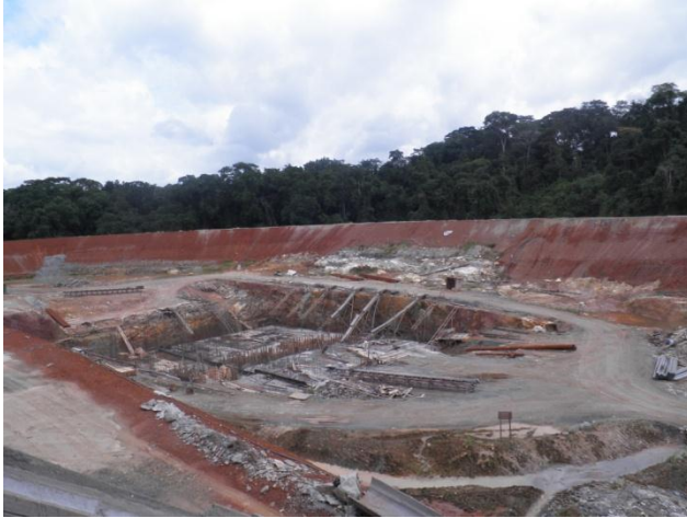
Fondations de l'usine de pieds à l'intérieur du batardeau.
