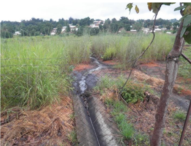
Centrale de NGAOUNDAL
