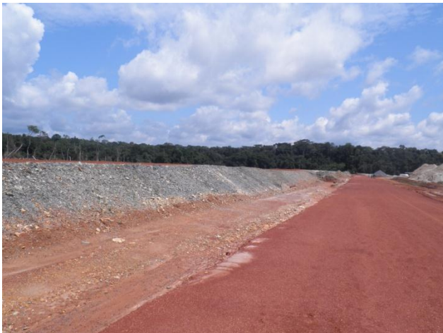
Réalisation de la digue principale.
