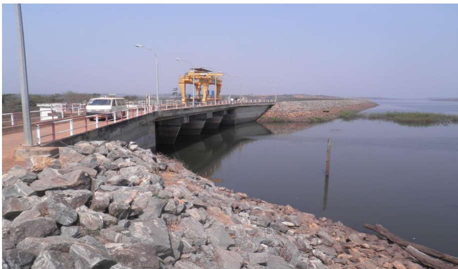
Figure 7: Vue du barrage réservoir de Mapé
