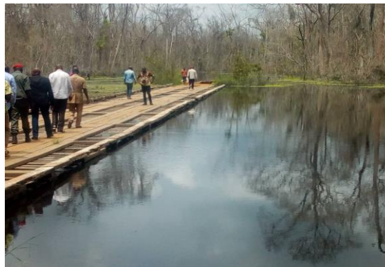
Dégradation des formations végétales et remontée des eaux du pont de Ngalla
