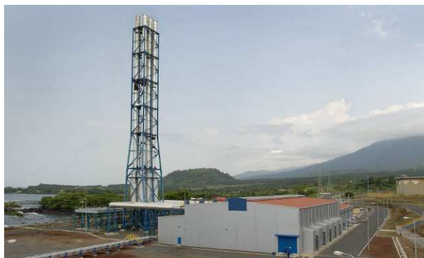
Figure 3 : Vue de la centrale de Limbé ( 85 MW )
