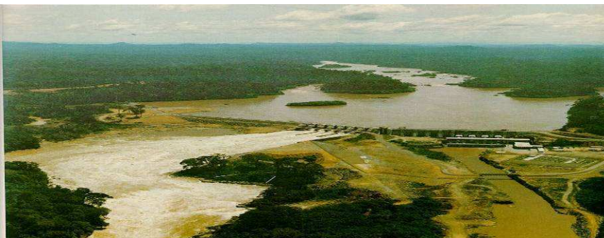
Figure 4 : Vue aérienne de l'aménagement de Song Loulou sur la Sanaga
